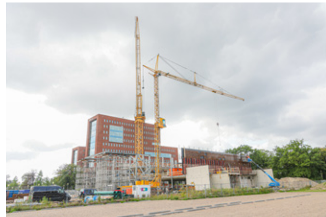
Nieuwbouw Meldkamer Oost Nederland naast bureau in Apeldoorn.
