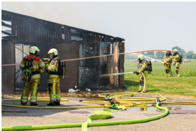
Grote brand in schuur met asbest Lemelerveld.
