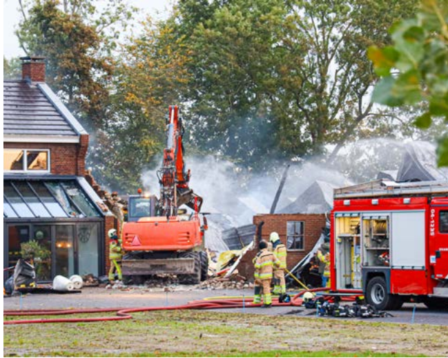
Grote brand in schuur Blokzijl
